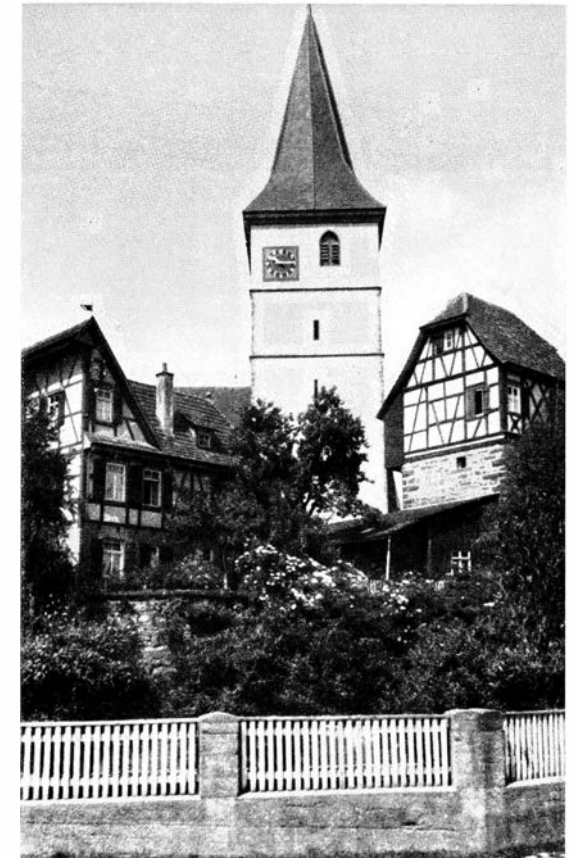
Merklingen, Blick über den ehemaligen Graben auf überbaute Teile der Wehrmauer, Rechteckturm und Kirchturm
