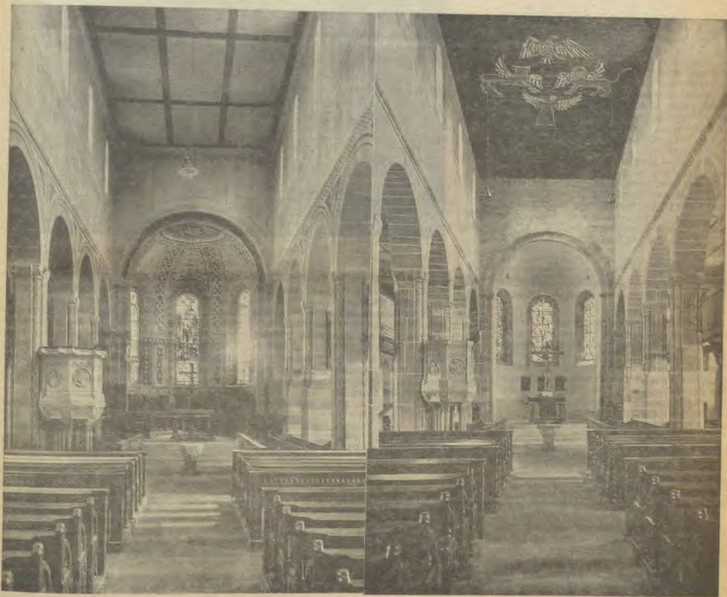
Das Hauptschiff der Martinskirche, vor und nach der Restaurierung
