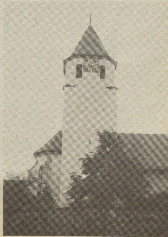
Blick von Norden
